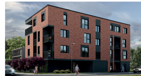
Widok na budynek
