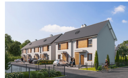
Widok od strony ulicy
