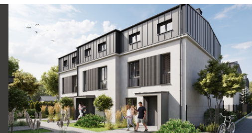
Widok osiedla od wejścia do budynku
